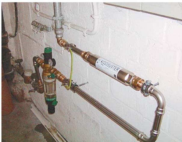
In dem etwa 30 bis 45 cm langen Messingzylinder befindet sich eine hochreine Zinkanode. Bild: Immeo Wohnen
